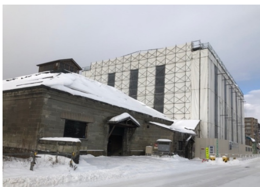
旧日本郵船の建物は工事中で、覆いに包まれて見えませんでした
