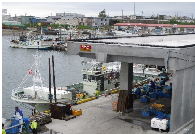
岸壁を屋根で覆い衛生管理を進める漁港区の風景
