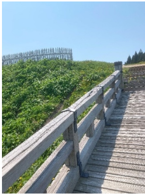
海側の橋から見た勝山館の入口
