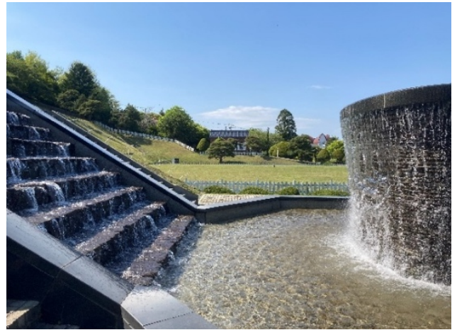
稼働する日本最古の「元町配水場」
